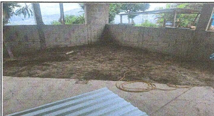
Foto 3: Mejoramiento de piso del aula de tipo portico
