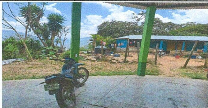
Foto 1: Mejoramiento de levantado de muros y estructura de columnas
