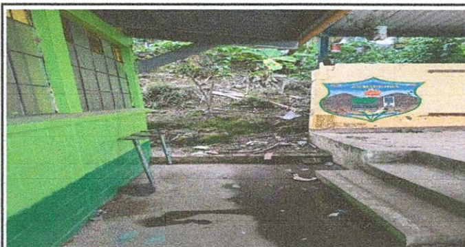
Foto 6: Mejoramiento muro perimetral
